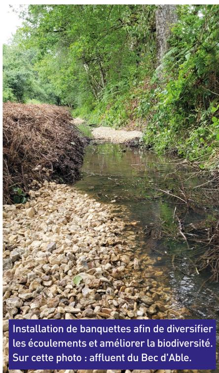
Installation de banquettes afin de diversifier les écoulements et améliorer la biodiversité. Sur cette photo : affluent du Bec d'Able.
