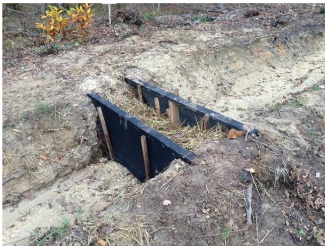
*Exemple de filtre à paille en phase travaux*
